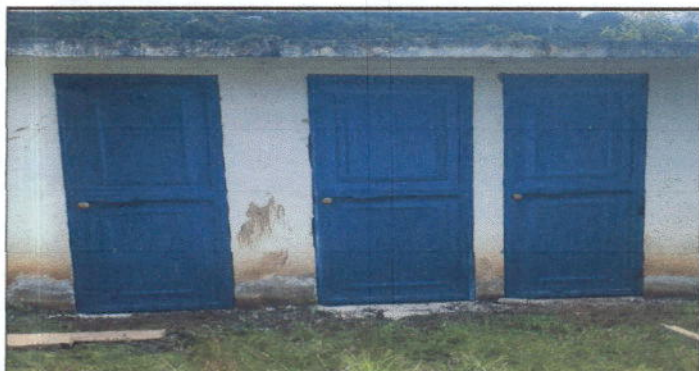
Foto 5: Fabricación e instalación de puertas de metal en módulo de baños
