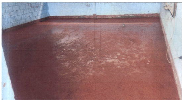
Foto 3: Sustitución de piso de torta de concreto en módulo de aulas
