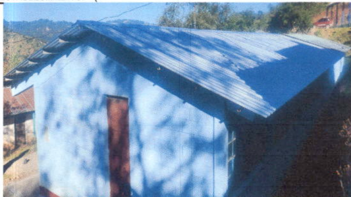
Foto1: Sustitución de lámina, por lámina troquelada aluzinc calibre 26 en módulo de aulas
