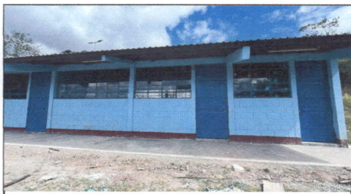
Foto 4: Fabricación e instalación de puertas de metal en módulos de aulas
