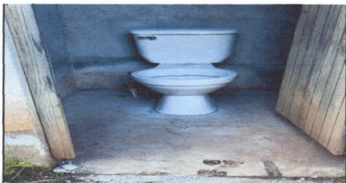
Foto 6: Sustitución de inodoro en módulo de baños.
